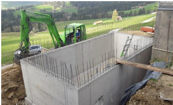
Neuer Güllekasten erstellt auf der Alp Trognerdürren Bild: Bruno Looser
