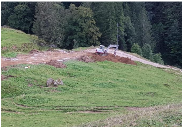
Strassensanierung zur Alp Eugst Bild: Michael Steiner
